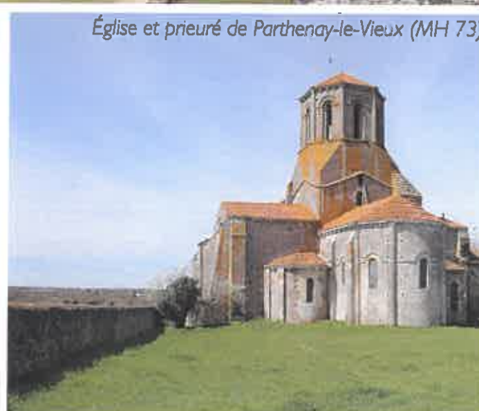
Église Saint-Laurent (MH 71)
